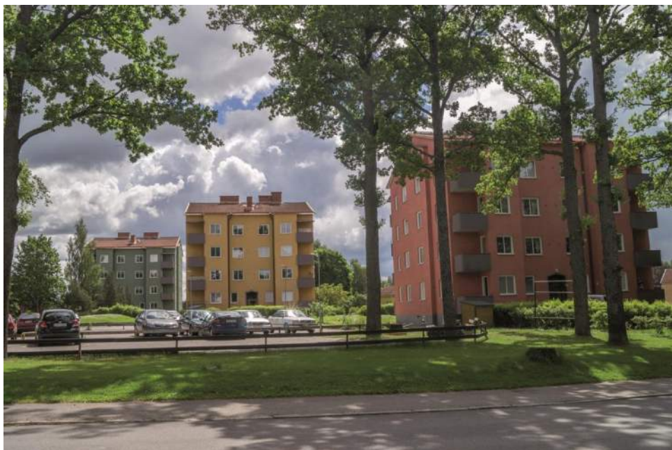
Punkthus på Nanolfsvägen. Kulturmiljöprogrammet Finspångs kommun, 2014.
