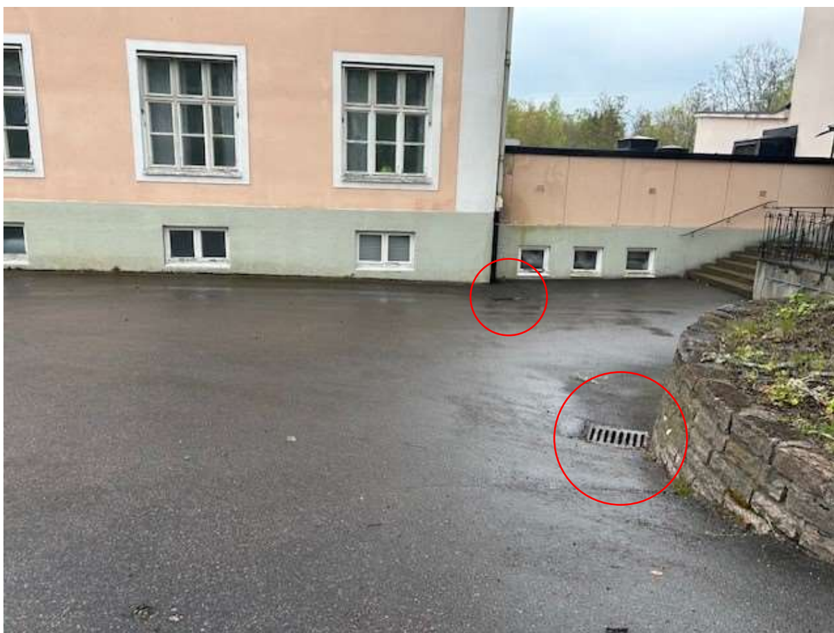
Figur 10. Lågpunkt på södra sidan av en av huskropparna, brunnar markerade och ingen ansamling av vatten syntes
