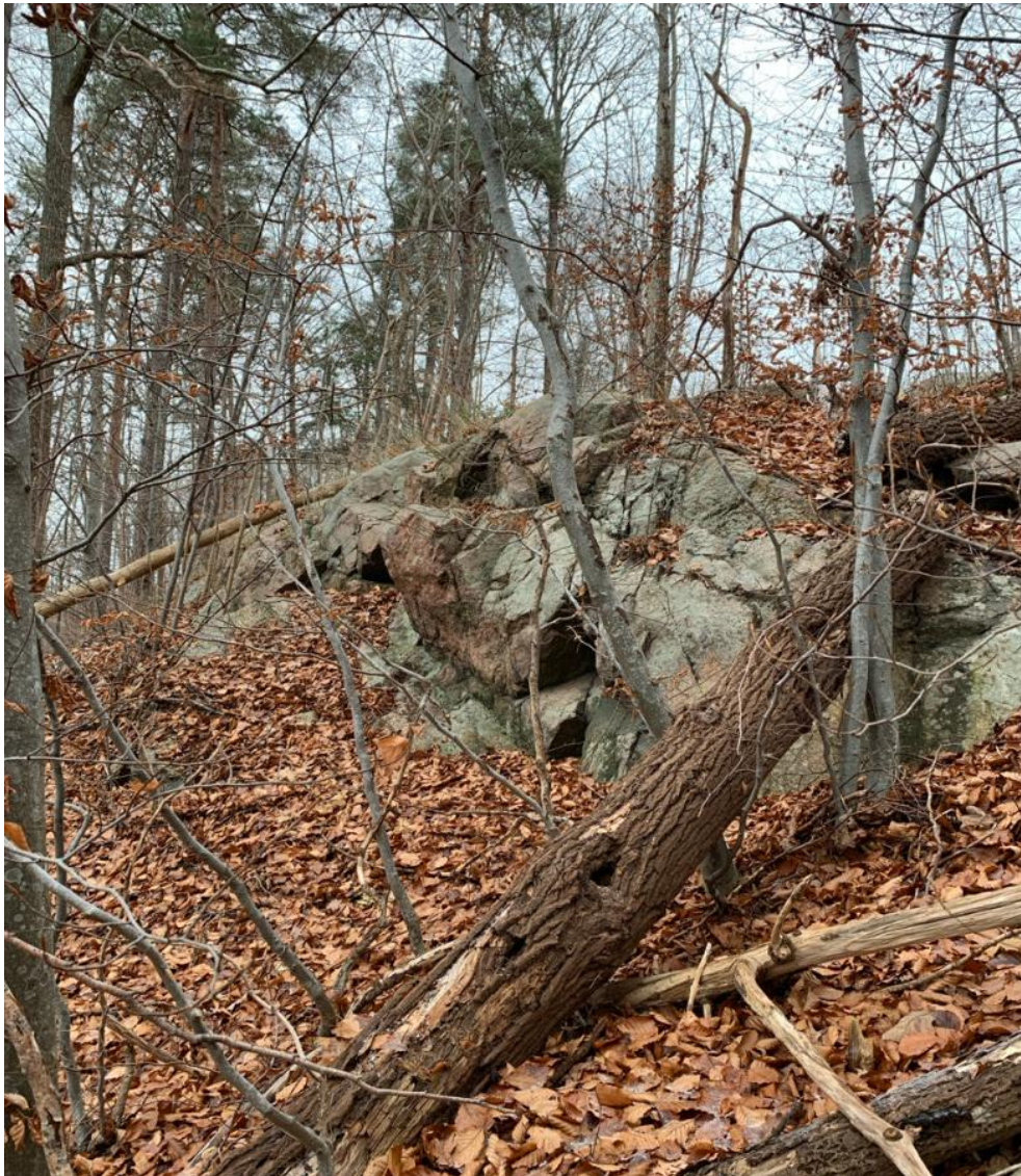
Figur 8. Bergslänt bakom kontorsbyggnad.
