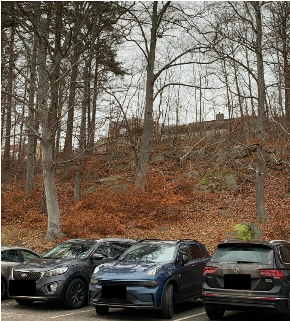
Figur 7. Bergslänt bakom kontorsbyggnad.
