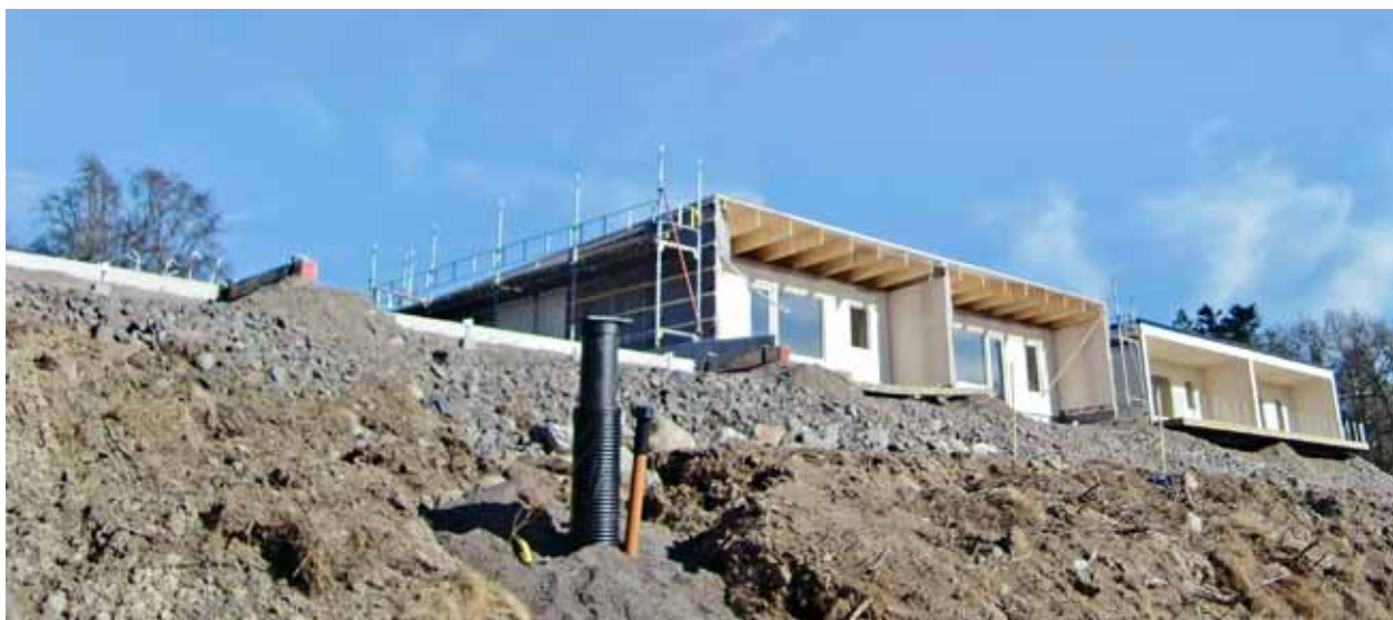
Bild från nybyggnation vid Lugnet.
