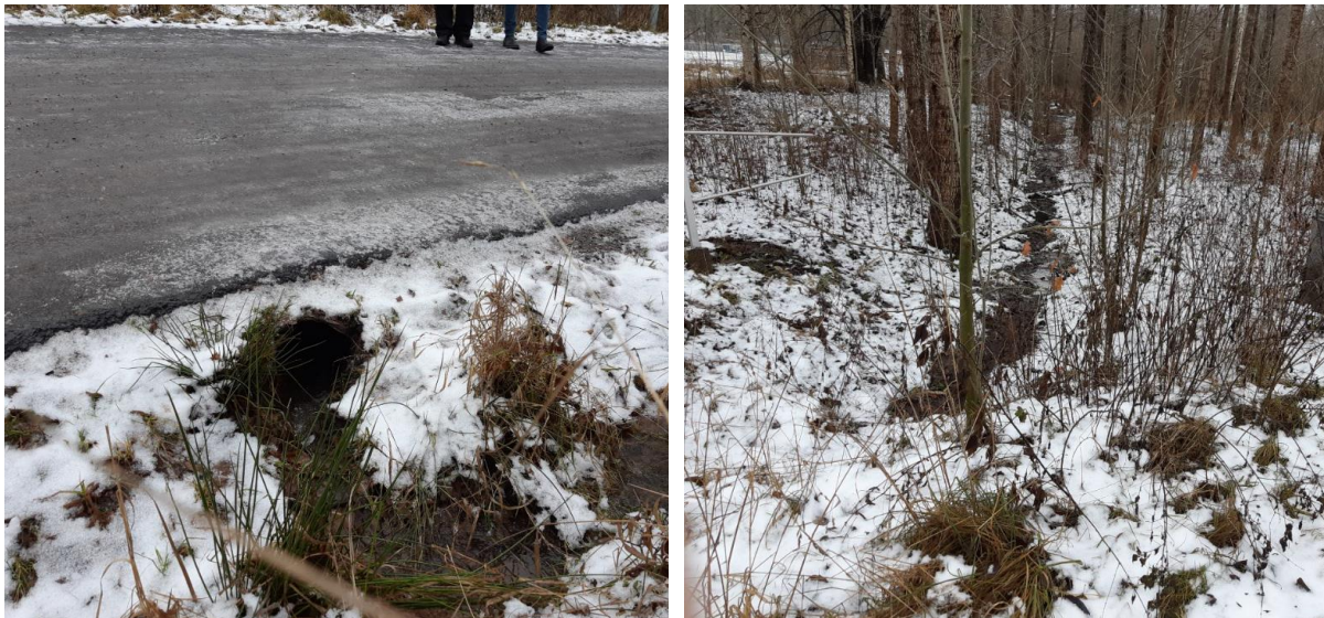
Figur 12. Trumma under Ånghammarvägen, dimension ca 300 mm (trumkapacitet ca 80-90 l/s), för lokalisering på karta se figur 5.
