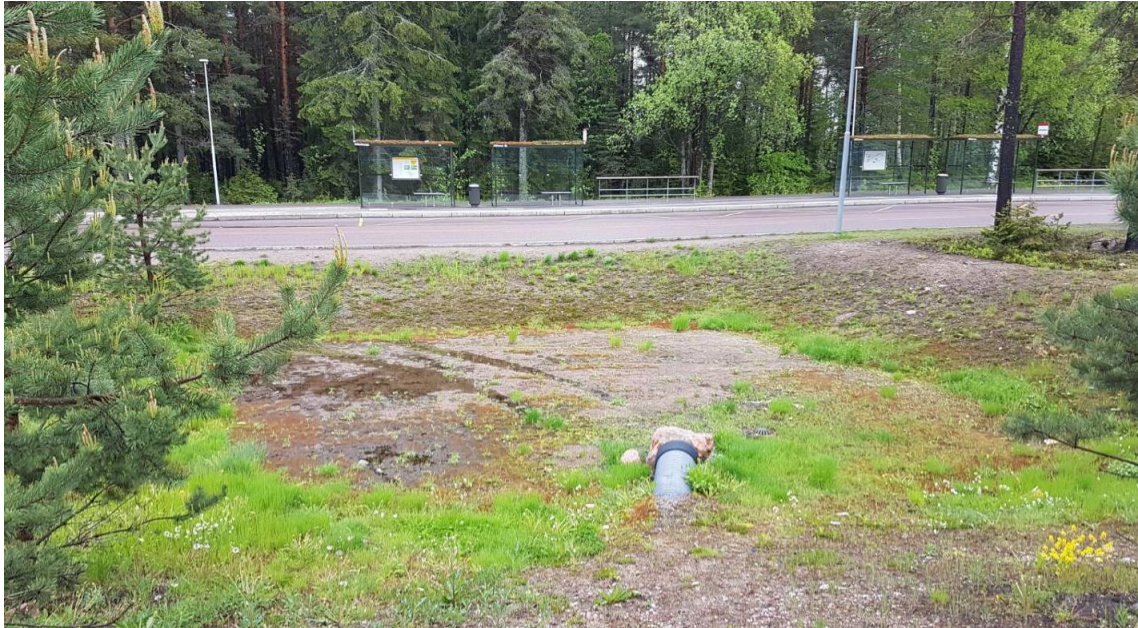
Figur 24. Exempel på utformning av torrdamm.
